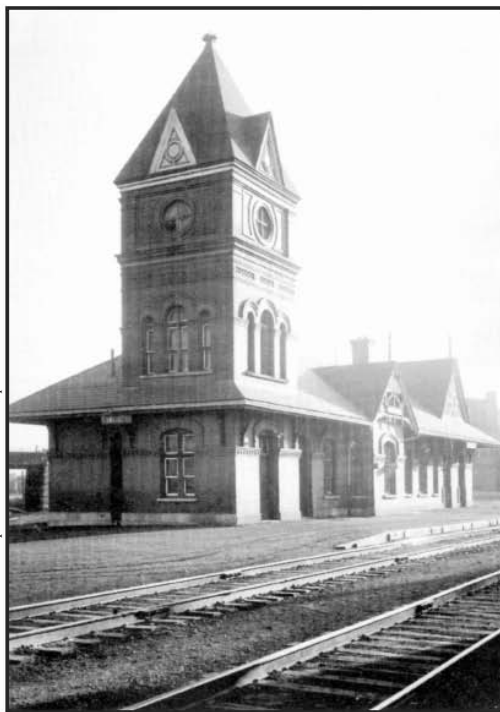
La gare de Saint-Henri en 1947, démolie dans les années 1950. Le site est maintenant occupé par le CLSC de Saint-Henri.
