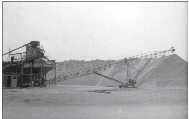
Vues du plan pour la préparation du sable à béton (1967).
